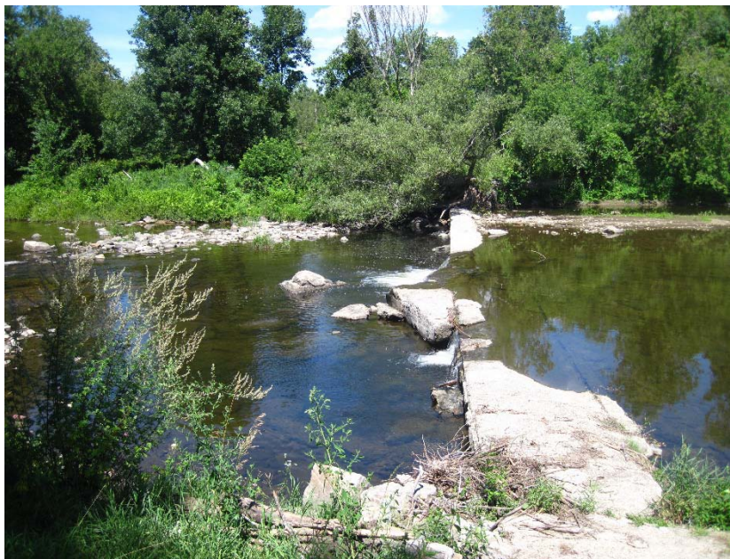
Barrage St-Onge (crédit :Ambioterra)
